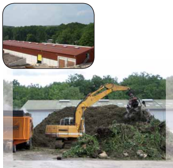
Plate-forme de compostage de Montlignon - 95
